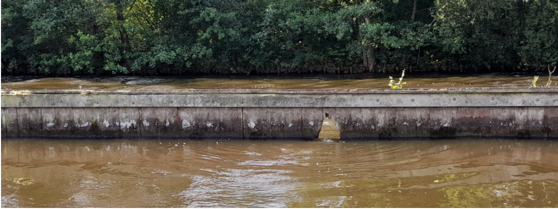
Figuur 1: Houten damwand tussen jachthaven en toegang naar Meerwijk
